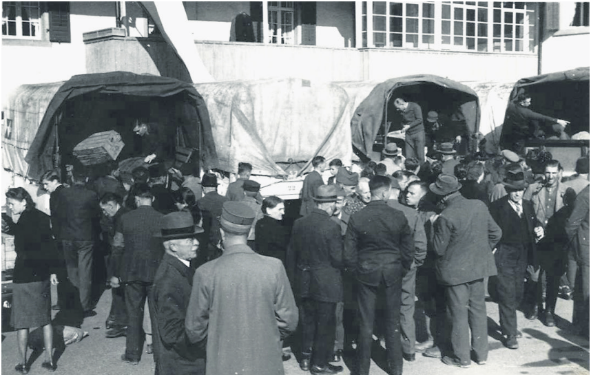
Auffanglager Alte Saline in Rheinfelden.
